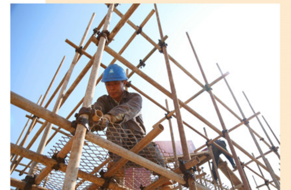
郊野公园施工现场,工人在紧张作业。
