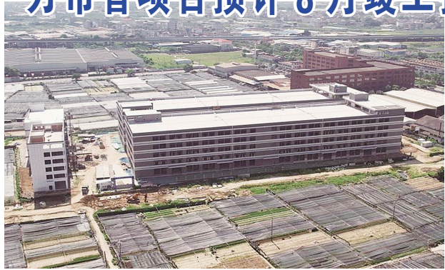
万市香智能化食品生产项目建设现场航拍图
