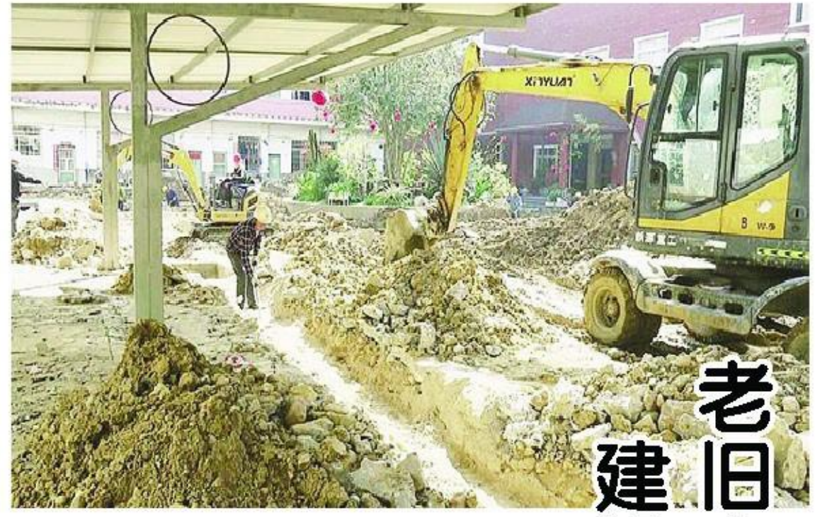
南靖县城老旧小区四期改造建设项目施工现场
