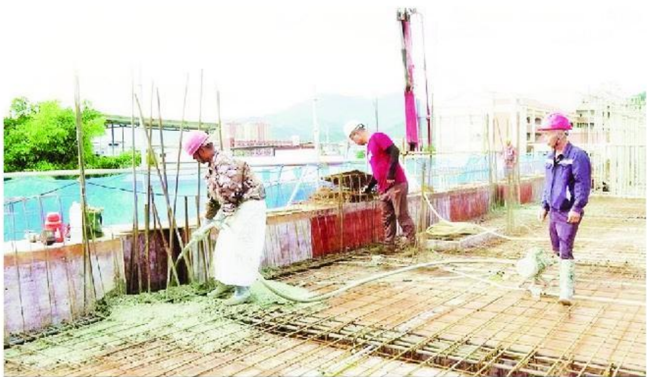
山城镇溪边村幸福院综合大楼项目:
