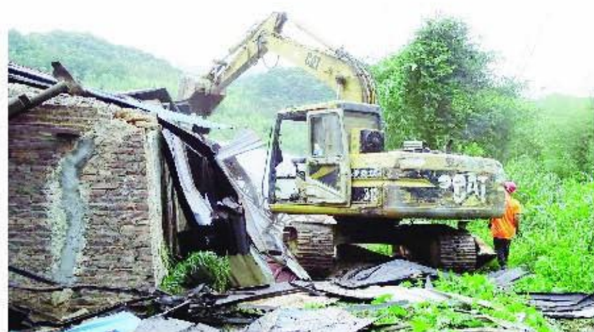
奎洋镇永顺达竹制品有限公司自行拆除违建建筑物
