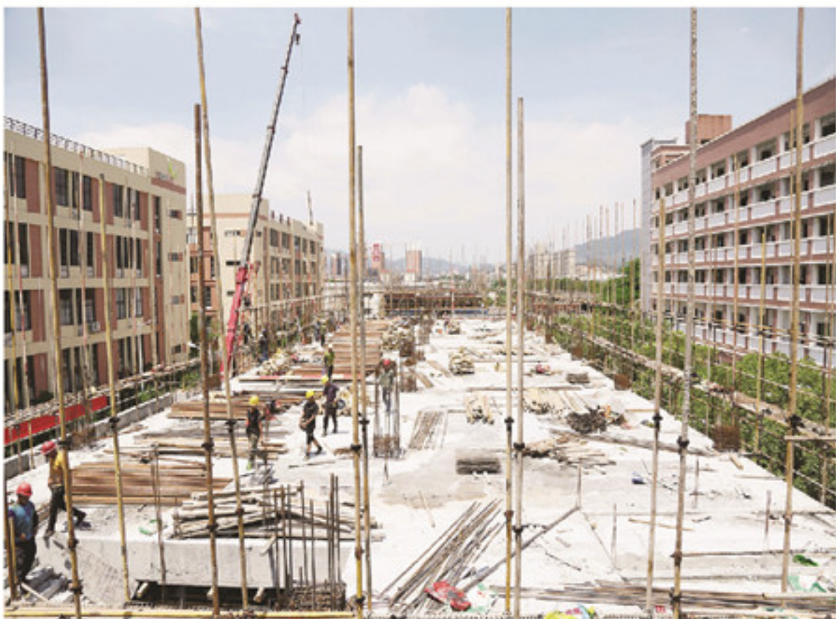
工人们正在进行大楼的钢筋绑扎和内架搭设。江峰 摄
