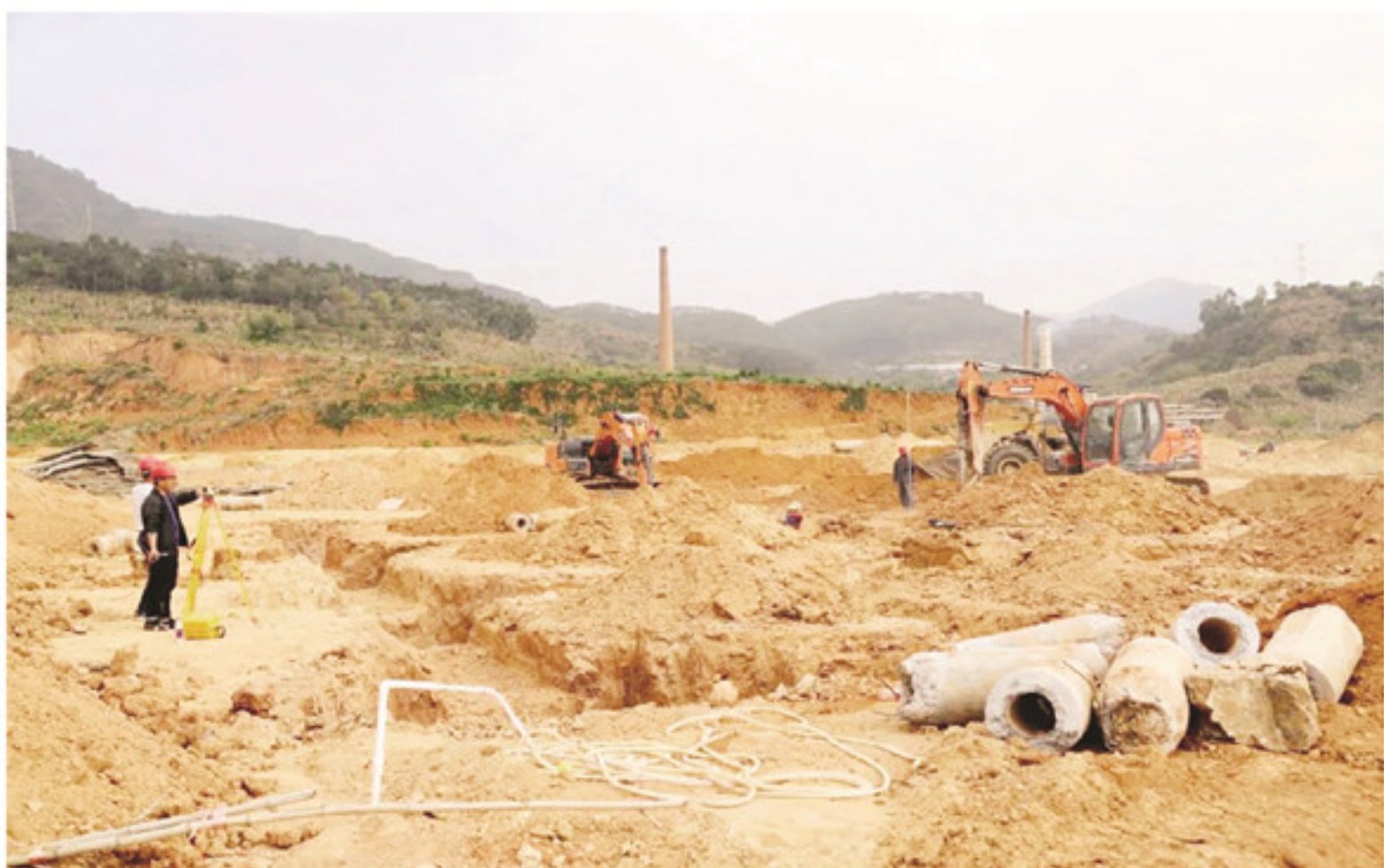
漳州理工职业学院新校区项目施工现场,数台挖掘机、压路机来回作业,现场一派繁忙。 陈智琛 摄
