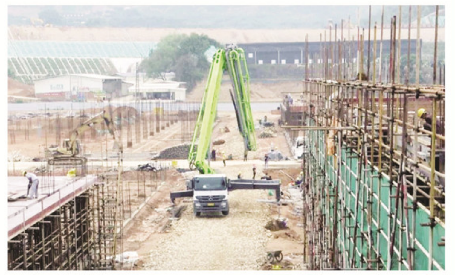
南靖联海商贸城施工方正在开足马力加快推进项目建设，预计今年下半年全部完工。
