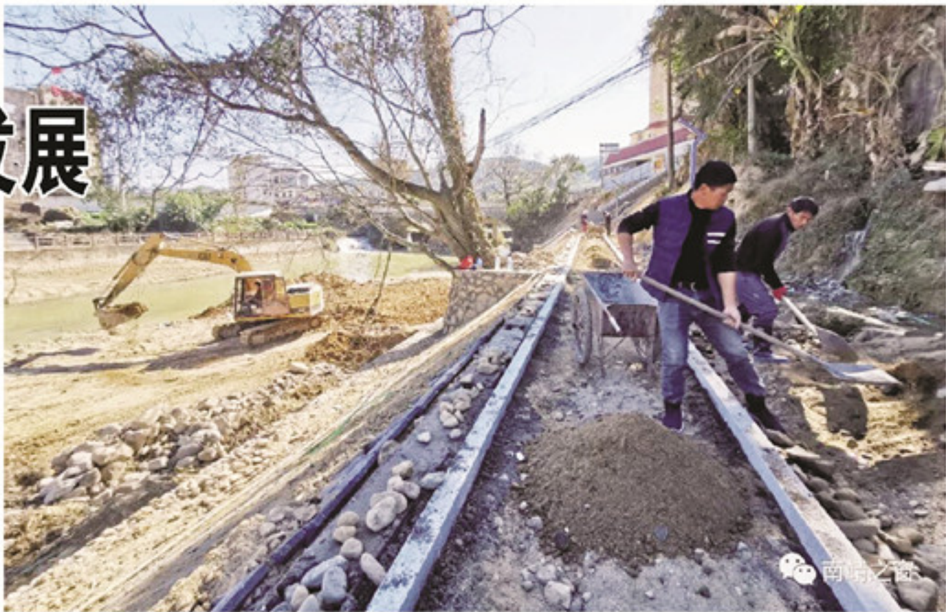
在船场溪书洋镇赤洲村至书洋村安全生态水系施工现场,工人们正在忙着铺设休闲步道。
