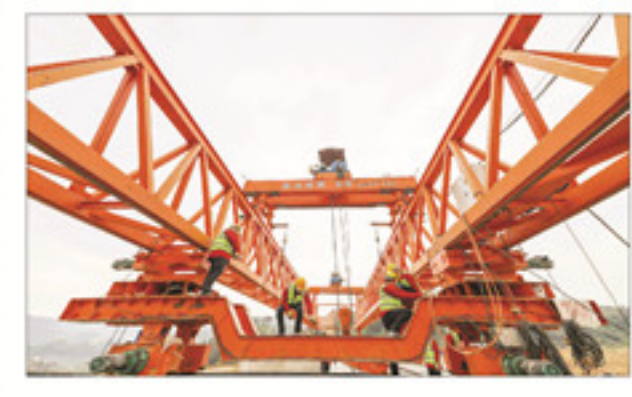
南靖基本建成安全便捷、畅通高效、绿色智能的现代综合交通运输体系,图为在津武高速(南靖段)A4标段施工现场,工人们正在进行桥梁施工作业。 谢成 摄
